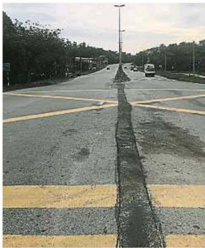
▲承包商已在马路底下埋下供电电缆，为街灯的运作做好准备。
